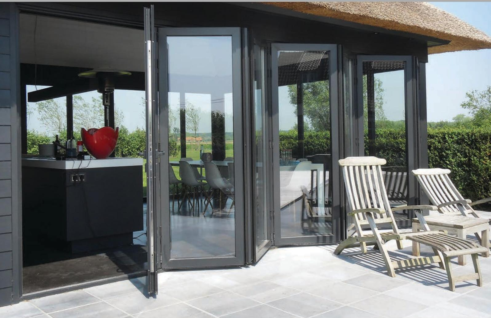
Le système de porte repliable ou de cloisons pliantes à coupure thermique vous permet de créer de larges passages. Dans le cadre dormant, on place des éléments pliables qui peuvent se déplacer soit vers la gauche, soit vers la droite. Montage d'un maucclair possible afin d'offrir plus de stabilité dans chaque situation.
